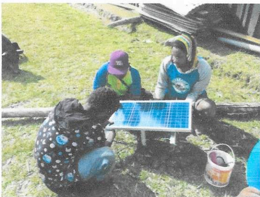
Afbeelding 3: De zonnepanelen worden gereed gemaakt voor installatie.
